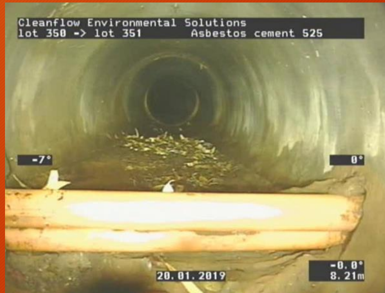
Horizon Power Service conduits.
